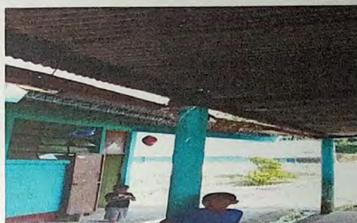
Foto 2: Laminas en mal estado ya deterioradas a punto de colapsar modulo III
