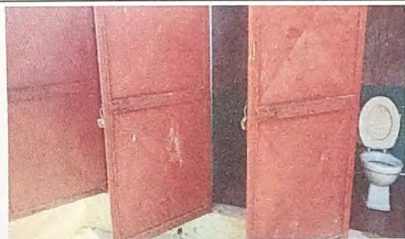
Foto 3: puertas del modulo de los modulos de baños en mal estado con corrosión sin pasadores y desprendidas de la pared
