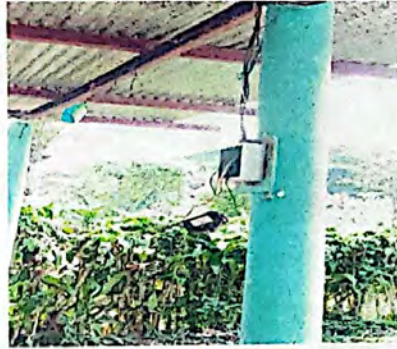
Foto 2: cajas de registro en mal estado sin flipones en los distintos modulos
