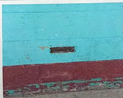
Foto 5: servicio electrico en mal estado cables sueltos y sin tomacorrientes modulos I, II Y III
