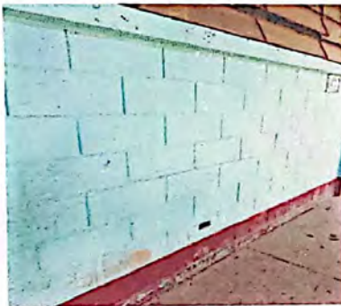
Foto 3: paredes en mal estado con pintura deteriorada y sin tomacorrientes modulos I, II Y III
