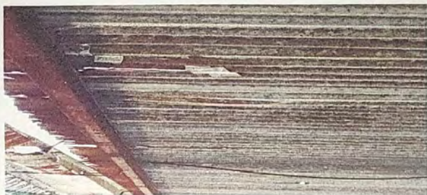
Foto 1: laminas del modulo III en mal estado con agujeros por oxidación
